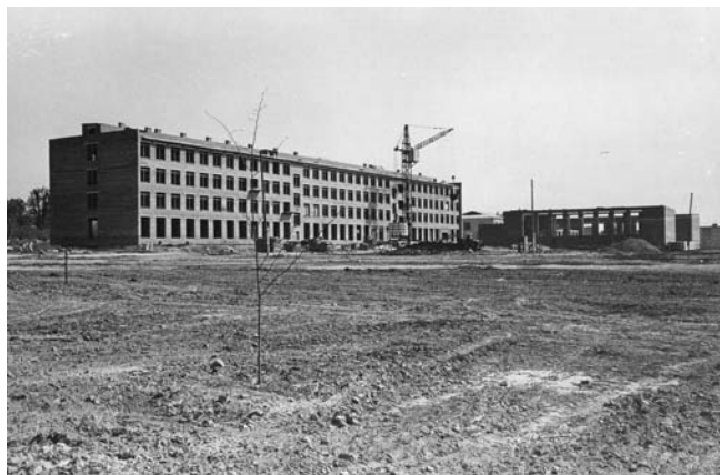
Будівництво навчального комплексу ВФ КПІ у 1960-х роках
