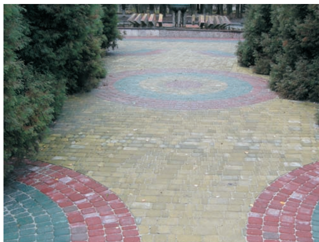
Тротуарна плитка, виготовлена в навчально-виробничому центрі «Будівельні технології»
