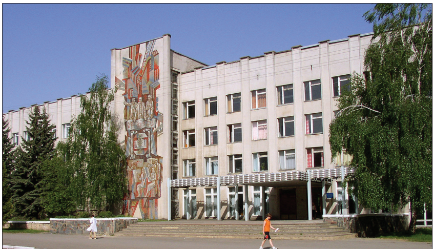
Кузня сучасних «Артинових» – корпус Інституту будівництва, теплоенергетики та газопостачання. Щороку тут випускають близько двохсот дипломованих фахівців зодчої справи, які працюють в містах не лише України, а й світу
