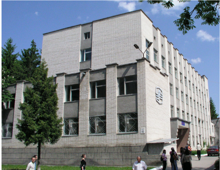
Корпус факультету комп'ютерних систем і автоматики
