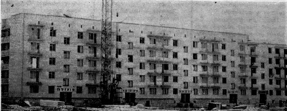
Завершується будівництво житлового будинку для співробітників інституту. Фото В. Садловського.
